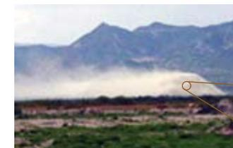
Erosión eólica (por viento) de un jale minero en un medio ambiente semiárido típico.
